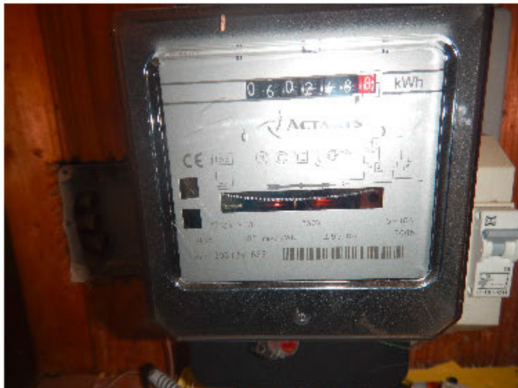
9. ábra Rendőrség főmérő 1x32 A
